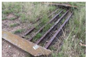
D1 Grid Facing NW
