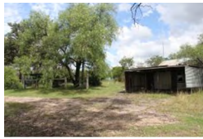
A2 Shed facing SE
